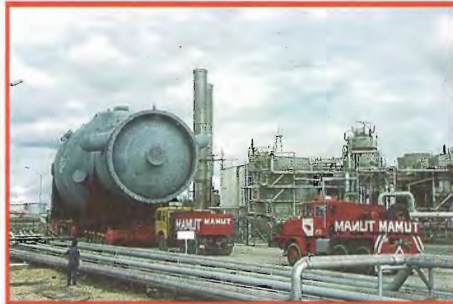
A SU paso se pudieron apreciar las 330 toneladas de peso del regenerador, la pieza más grande en el montaje y cuyas especificaciones permitirán reactivar el catalizador que se utiliza en el proceso de crackeo catalítico.
