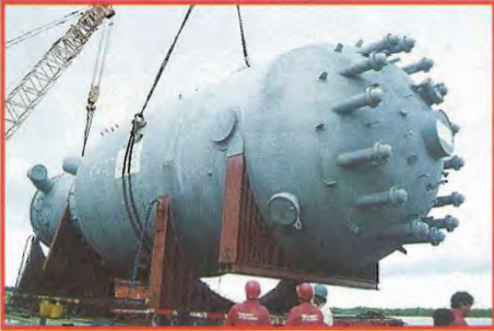
LA GRUA, con capacidad para mil toneladas, ubicó la pieza sobre los módulos y el recorrido continuó, pasando por los diferentes sectores de la refinería.
