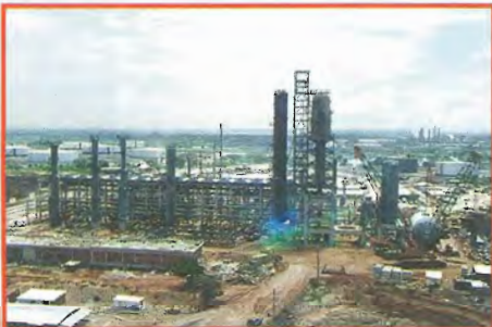
ASI, LA primera semana del mes de mayo, el cuerpo del regenerador pasó de la posición horizontal, en la que se movilizó, a el verticalismo que la ha de caracterizar en adelante.
